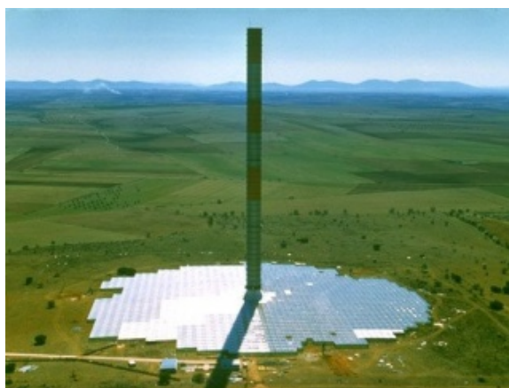
Hình 3.3 Tháp năng lượng Mặt trời Hệ thống sử dụng gương parabol tròn xoay định vị theo phương mặt trời để tập trung NLMT vào một bộ thu đặt ở tiêu điểm của gương, nhiệt độ có thể đạt trên 1500oC.
